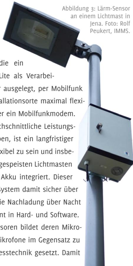
Abbildung 3: Lärm-Sensor an einem Lichtmast in Jena. Foto: Rolf Peukert, IMMS.
