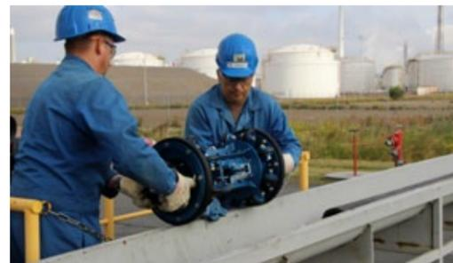
Einsetzen eines Lecksuchmolches der Firma ARS in eine Pipeline. Foto: Kathrin Butter, ARS Betriebsservice GmbH.
